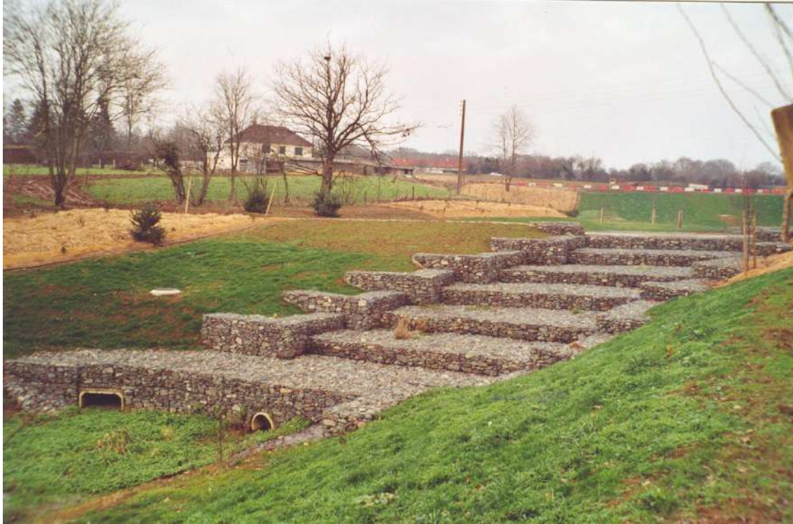
Déversoir en Gabions de forme escalier
