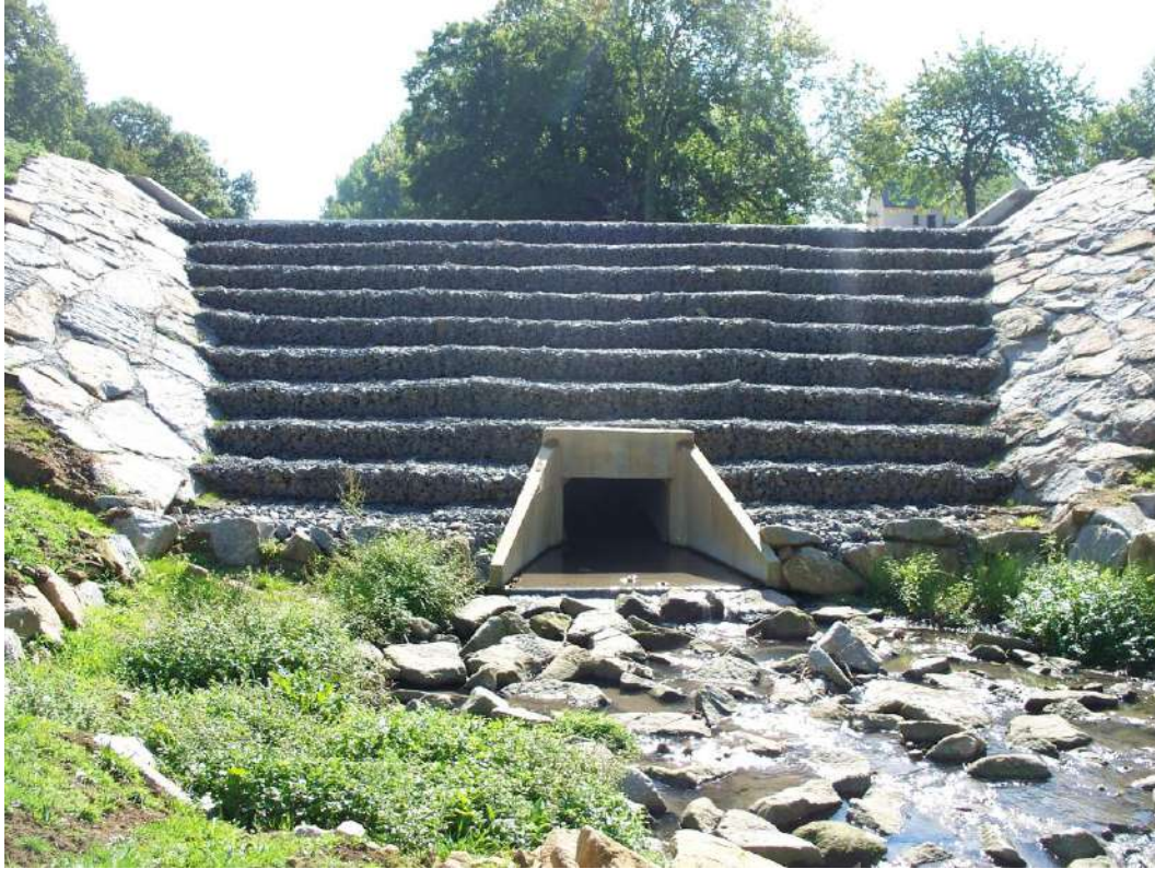
Déversoir en Gabions de forme escalier
