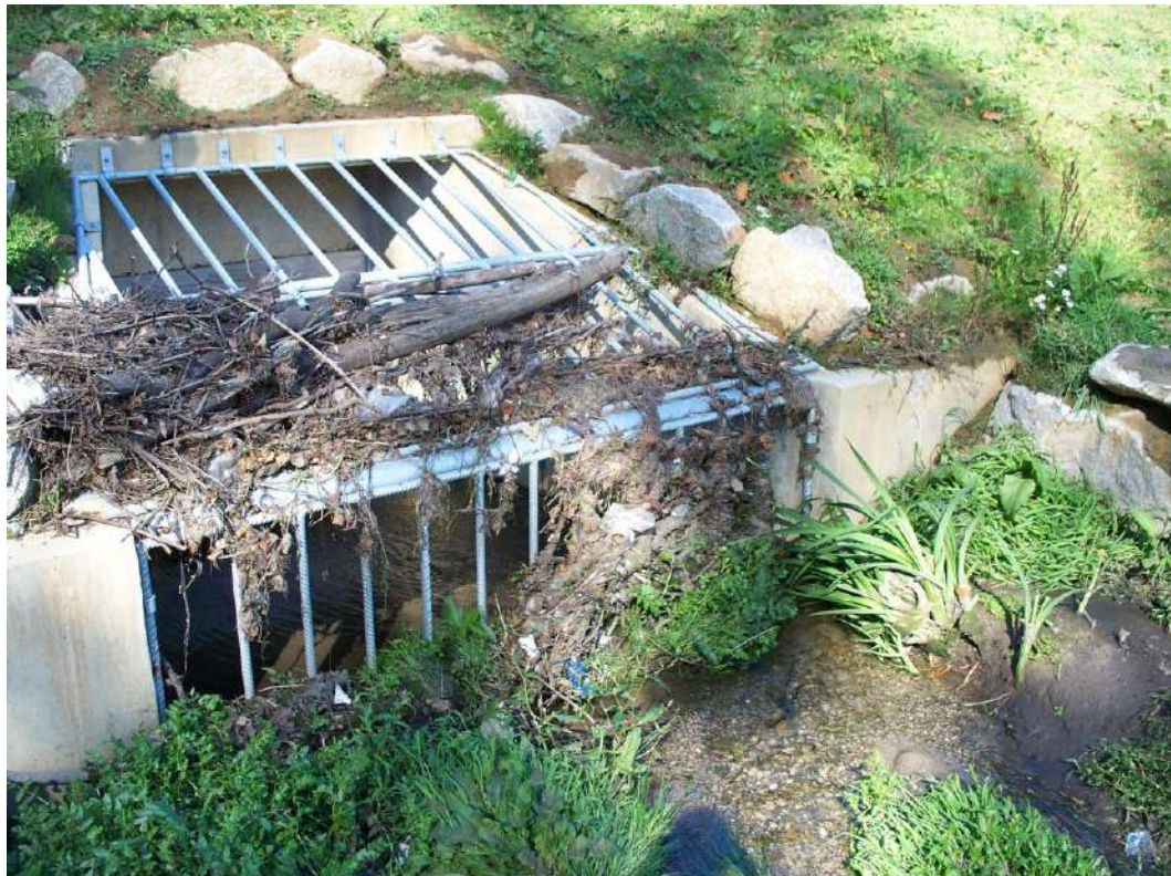
Ouvrage de fuite coté amont du barrage
