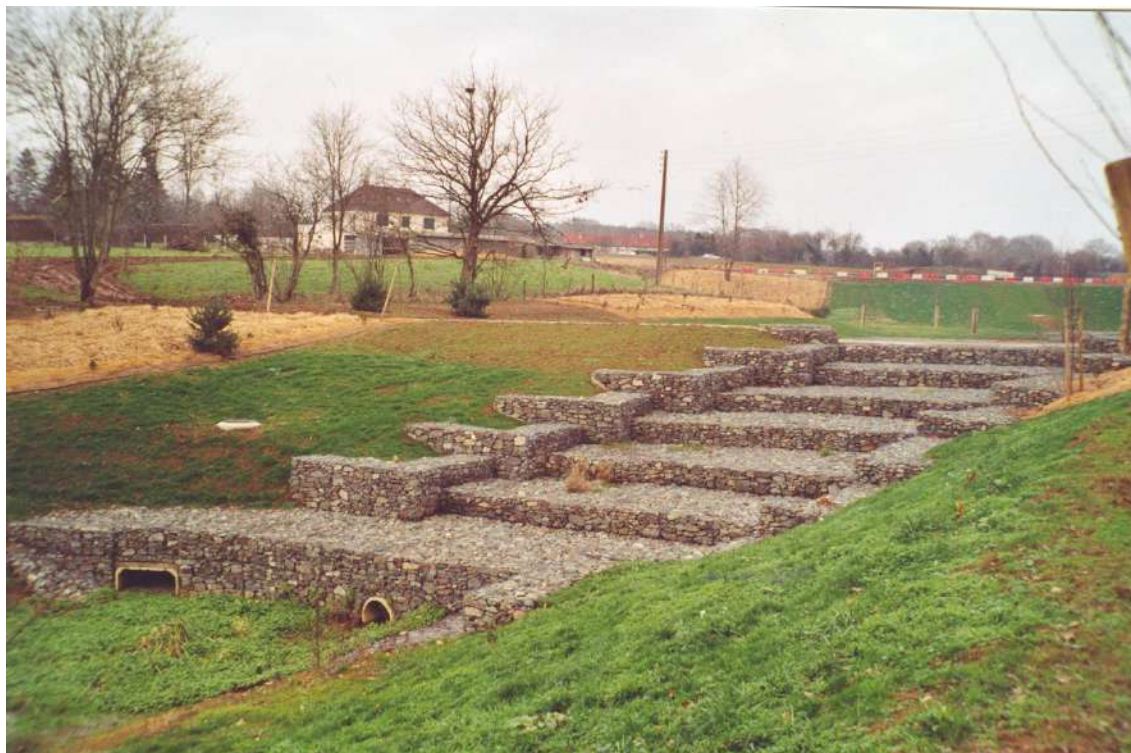
Déversoir en Gabions de forme escalier
