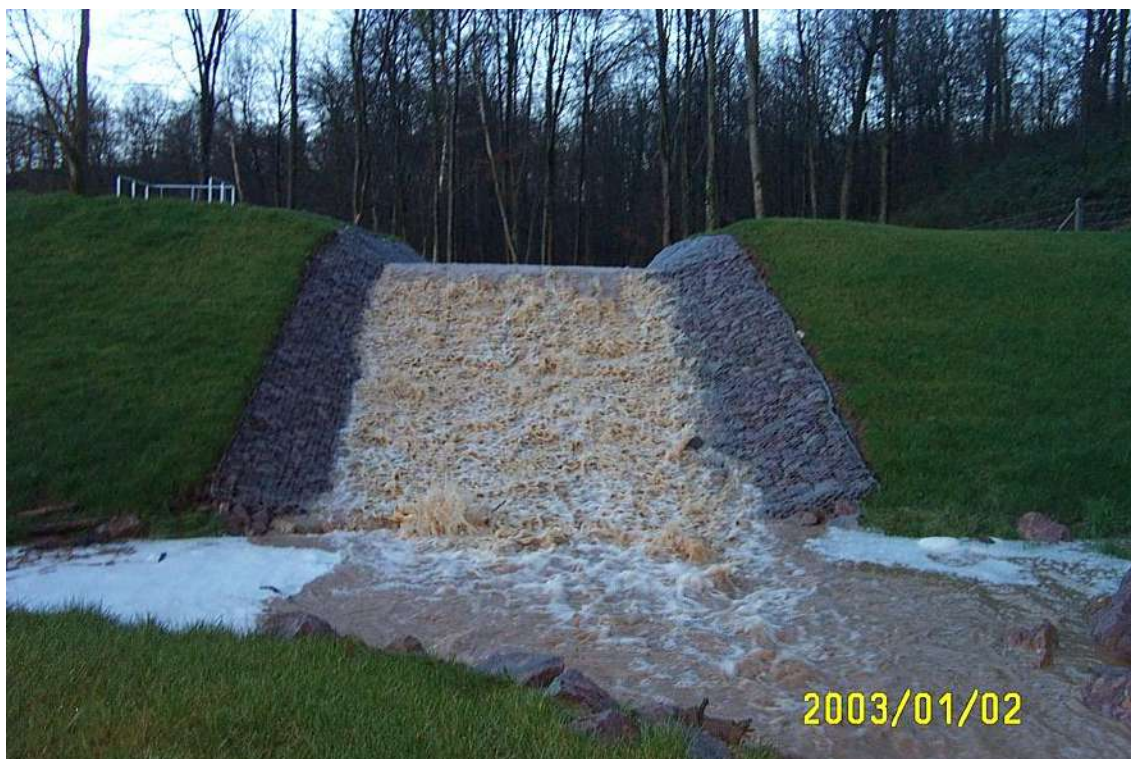
Déversoir rectangulaire en gabion
