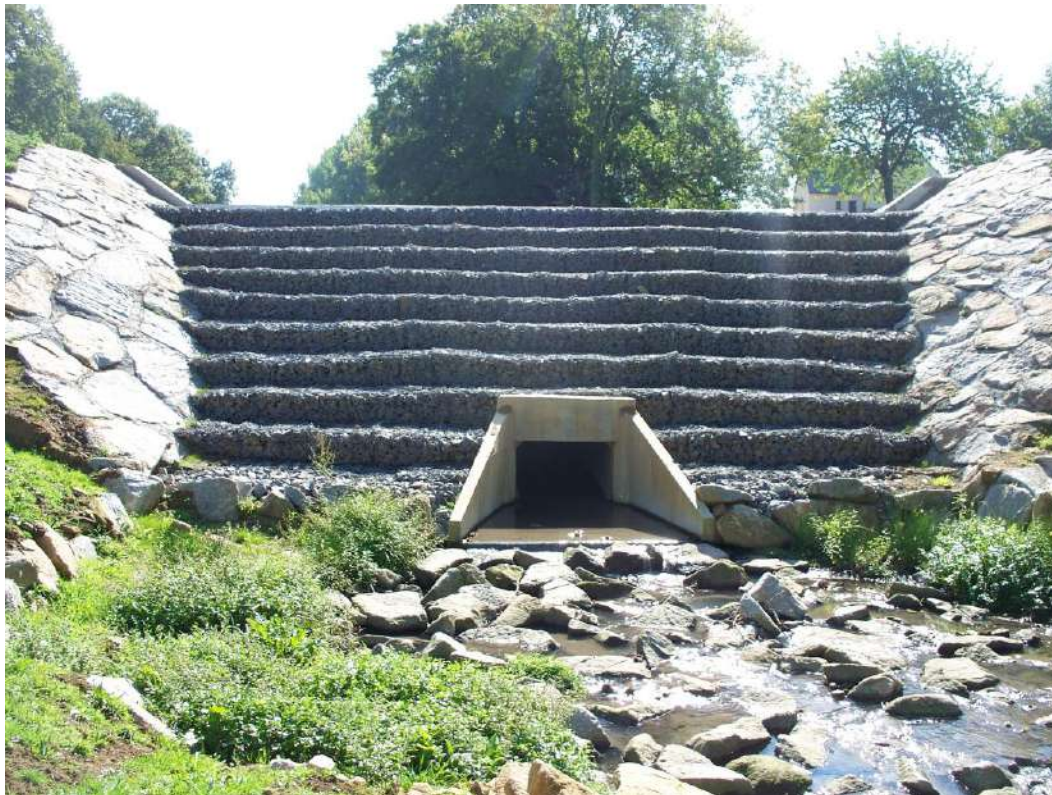
Déversoir en Gabions de forme escalier
