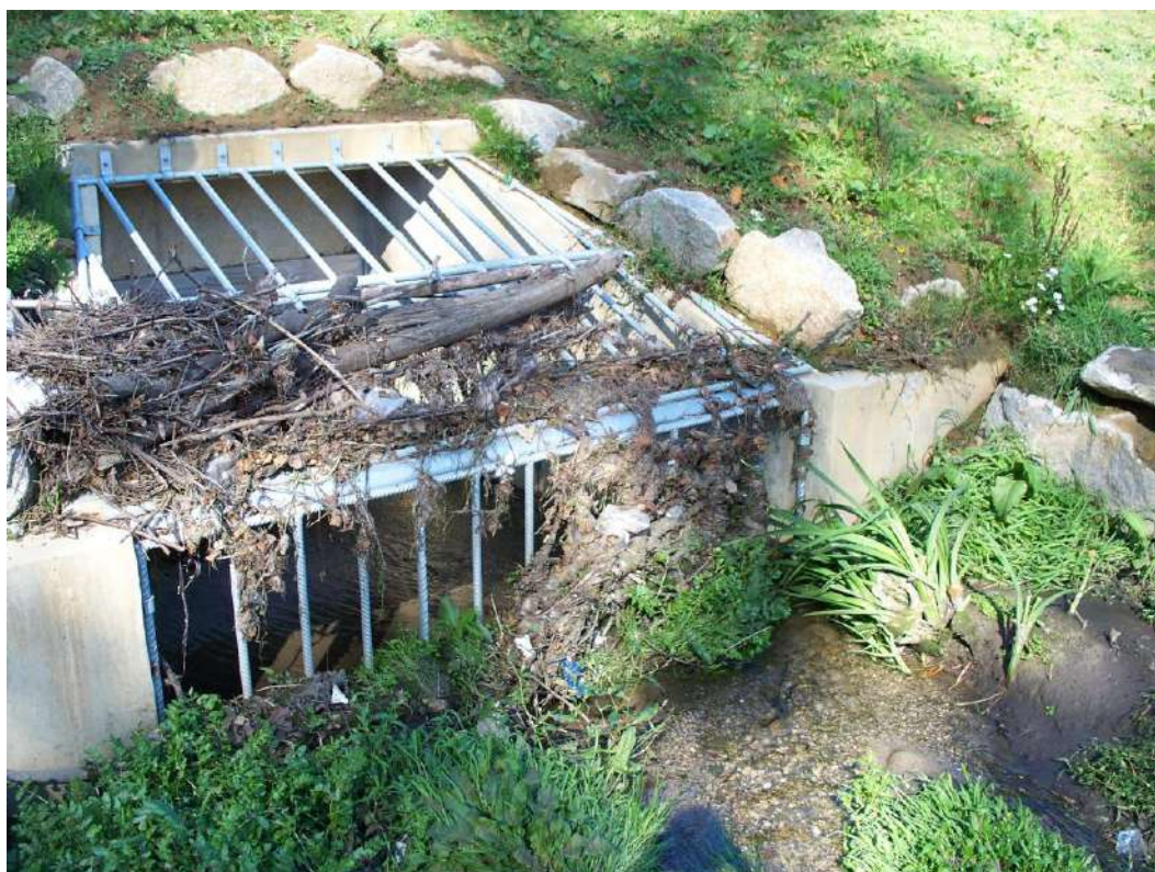
Ouvrage de fuite coté amont du barrage
