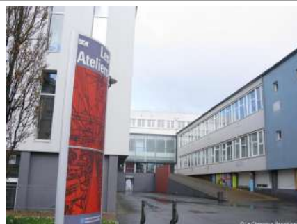
Usine Réhault, rue des Frères Dévéria, 1964
