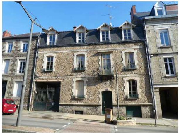
Le long de ce même Boulevard Jean Jaurès, un collectif datant de la période entre deux guerres.
