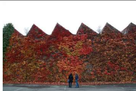
Usine Bertin depuis la rue de Nantes, ateliers sous sheds construits en 1912
