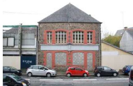
Ancien Patronage / Usine Bordeau & Tréhu, rue de Bonabry
