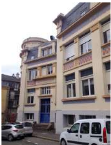
Usine Morel & Gaté, 3 rue des Recollets, Prévos & Gauvin architectes, 1927
