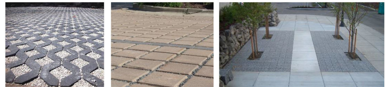
Structures gravillonnées Pavés poreux
