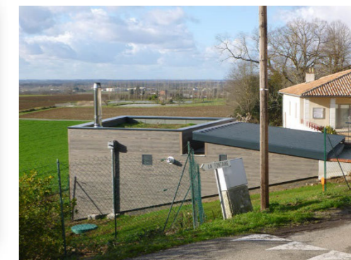
Chaufferie collective bois déchiqueté Commune de Lagarrigue (Antropik Architecture)
