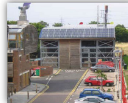
Chaufferie collective à cogénération Quartier Vauban / Freiburg
