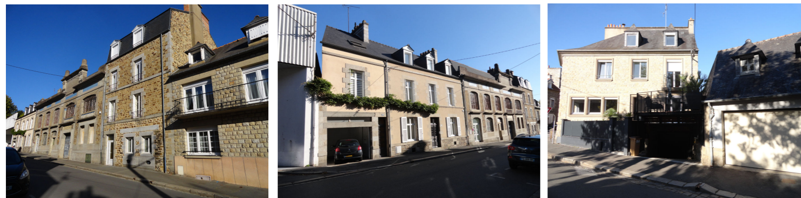
Photos 1 à 3 : front bâti le long de la rue Pasteur
