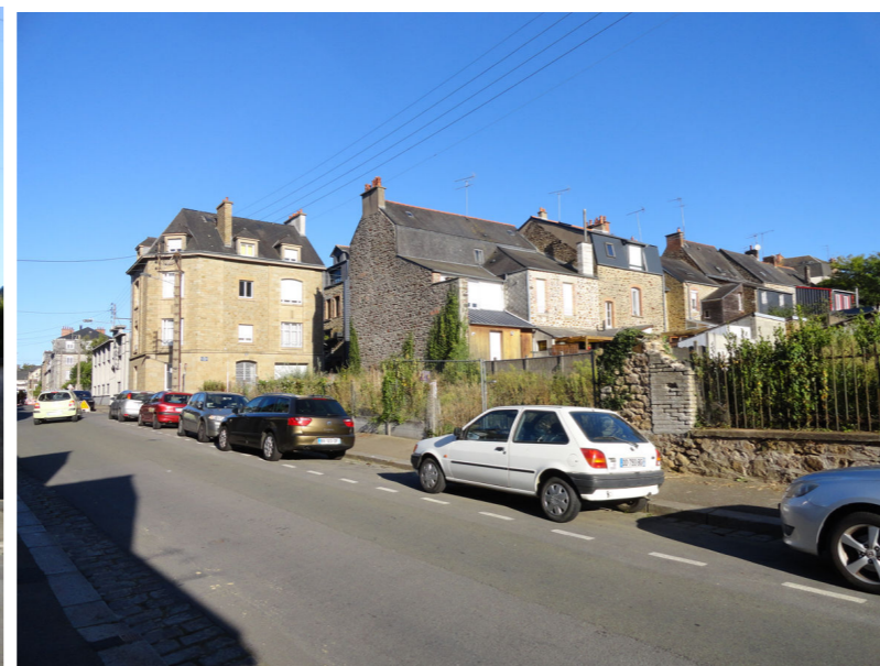
Photo 2 : Vue sur le bâti bordant la rue Amiral de Guichen (immeuble d'angle)
