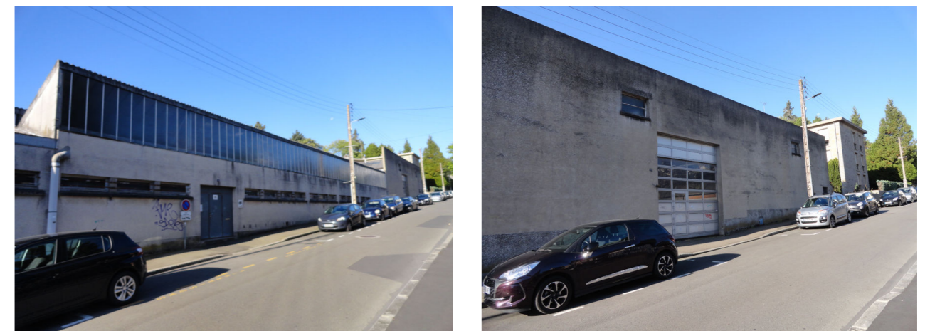
Photos 4 et 5 : arrières de l'usine Minelli et de l'ancien garage rue des Résistants Fougerais
