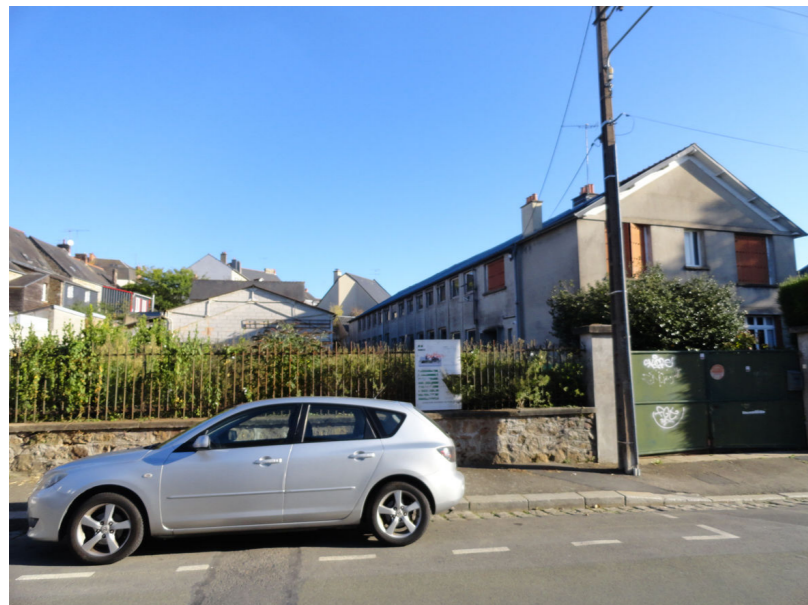
Photo 1 Vue sur le bâtiment de l'ancienne usine
